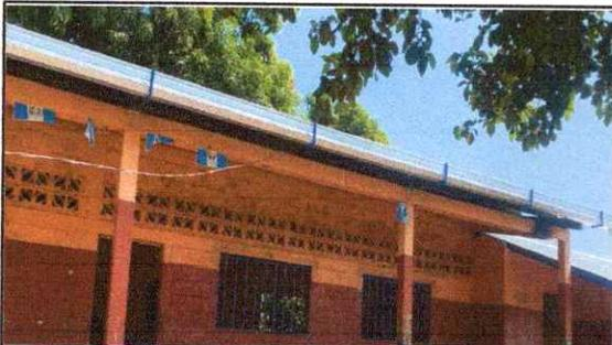
FOTO 9: Reparación de bajada de agua pluvial, tubo PVC 3" En corredor de aulas
